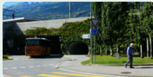
Plantations et végétalisation d'un mur sous les voies CFF en gare de Viège
